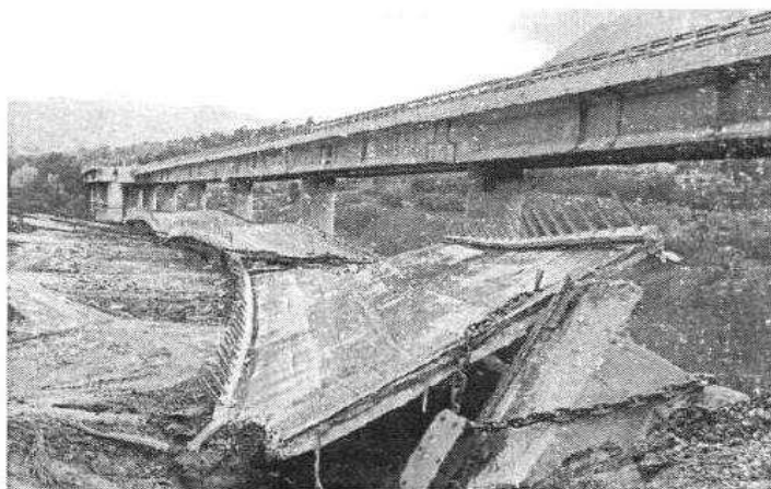
La carreggiata in direzione Catania dell'A19 dopo la demolizione
